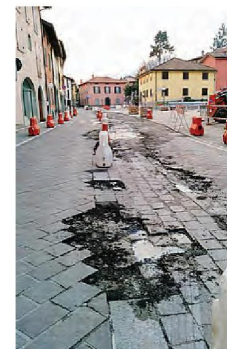
Partiti i lavori in piazza Lemine
